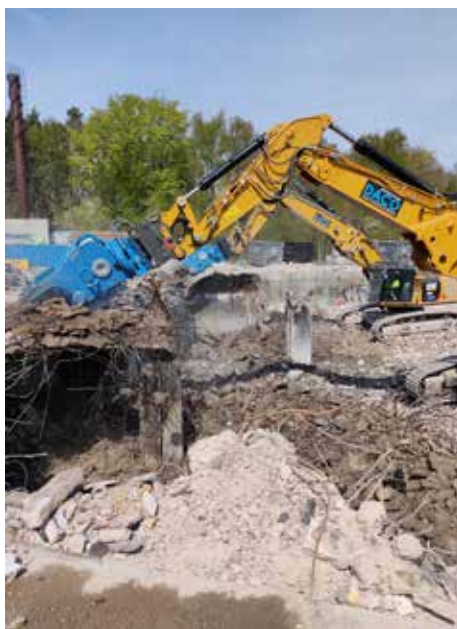
Totalrivning av skola.
